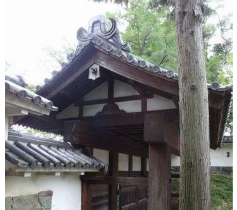
切妻の屋根が鏡柱と控柱を 覆うようにに乘せられてい ます。
